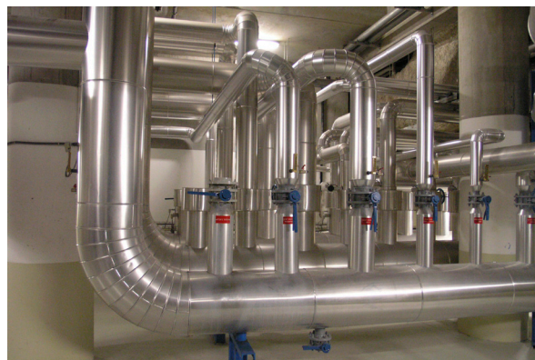
Heat pump of Grimaldi Forum © Direction de l'Environnement- Monaco
